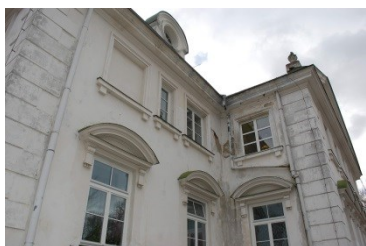
Pałac przed remontem
