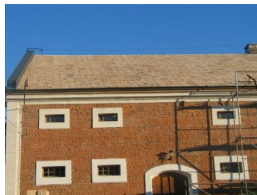
Dach spichlerza po remoncie
