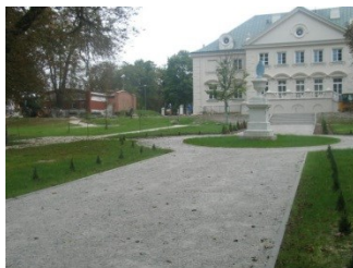
Pałac po remoncie
